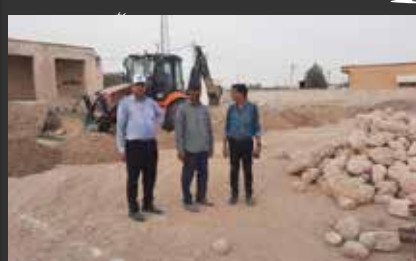
آغاز عملیات اجرایی
